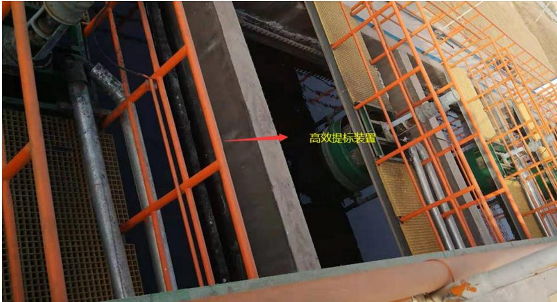
流程C: GT高效过滤装置, 以天然石英砂为填料, 通常还有锰砂和无烟煤, 作为对经澄清(沉淀)及吸附处理后的给水处理或污水经二级处理后的深度处理。
