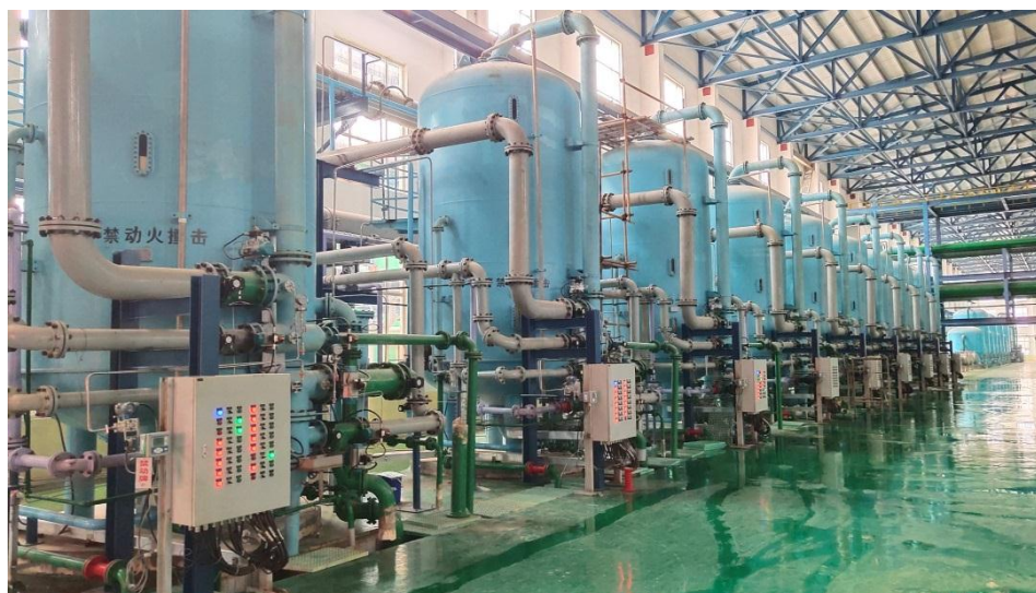
中科炼化凝结水项目
