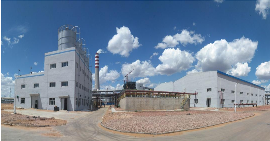
中天合创废水处理及回用装置 EPC 项目
